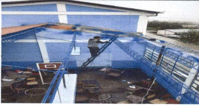
Foto 1: Instalación de lámina troquelada y mantenimiento de estructura de metal
