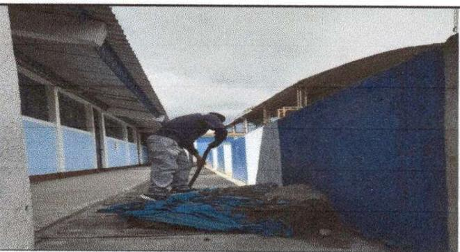
Foto 5: Sustitución de piso de tierra por torta de concreto
