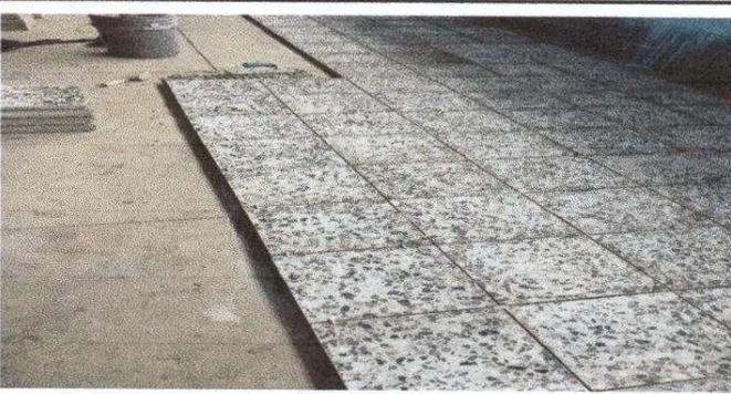
Foto 3: Instalación de piso de granito
